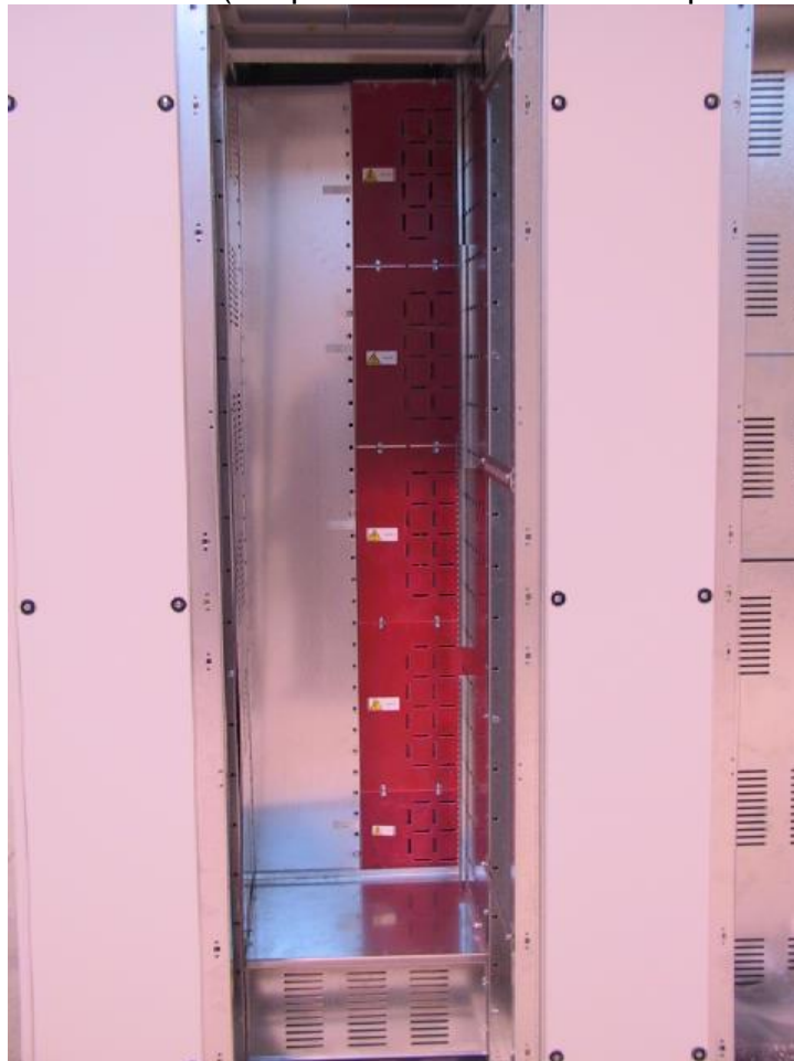
In fase di montaggio (Derivazioni da sbarre omnibus + uscite 1250A)
