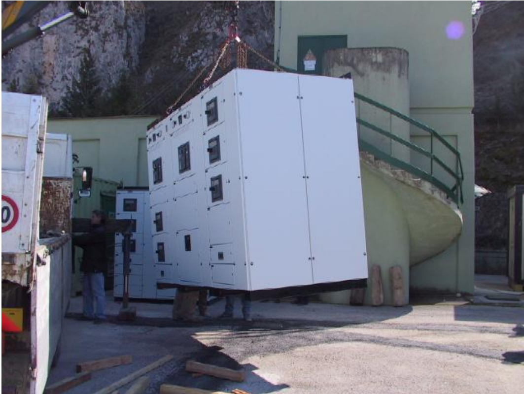
Fase di scarico in cantiere
