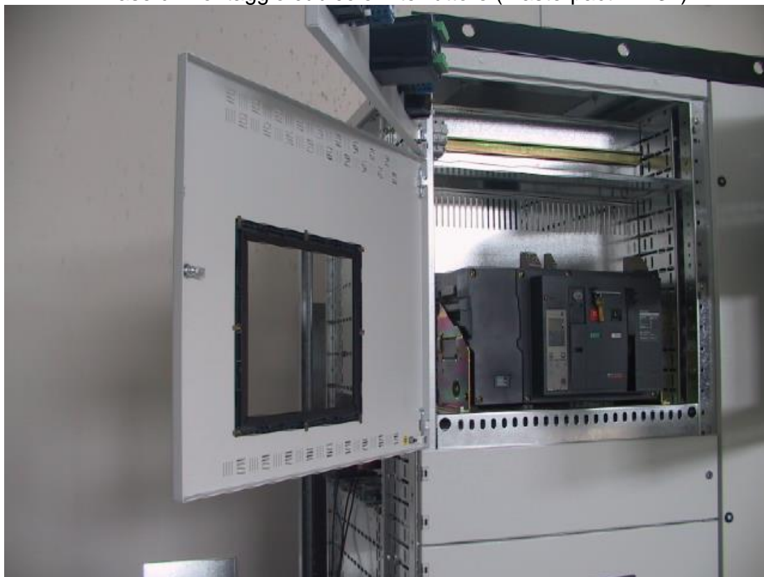
In fase di montaggio cubicolo Interruttore (Masterpact NW32)
