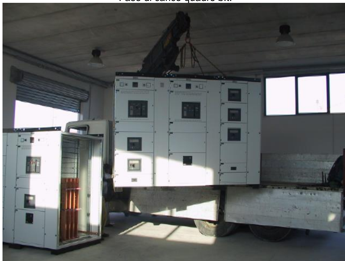
Fase di carico quadro b.t.
